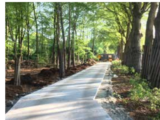
Gammel skovbund klargøres til ny cykelsti, Holland. Beton belægningen er udlagt.
