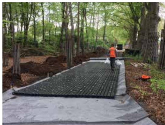
Gammel skovbund klargøres til ny cykelsti, Holland. PermaVoid kassetter udlagt.
