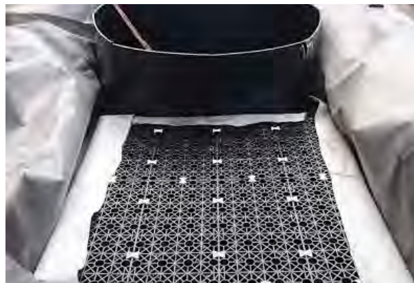
Trægrube med ArboRaft kassetter og RootGuide. Lokation: Ndr. Fasanvej, Frederiksberg.
