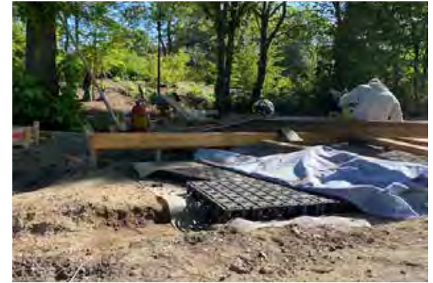
Nye parkstier omkring gamle træer. Lokation: Remiseparken, Amager.
