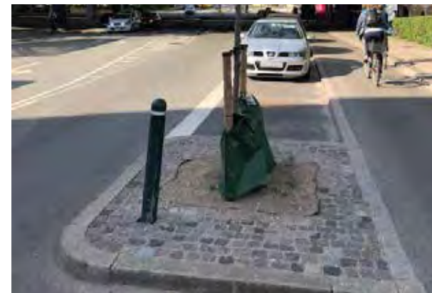
Belægning færdiggjort over trægrube. Lokation: Ndr. Fasanvej, Frederiksberg.
