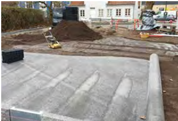
Klargøring til ny parkering under eksisterende træer. Lokation: Kragssbergvej, Odense.
